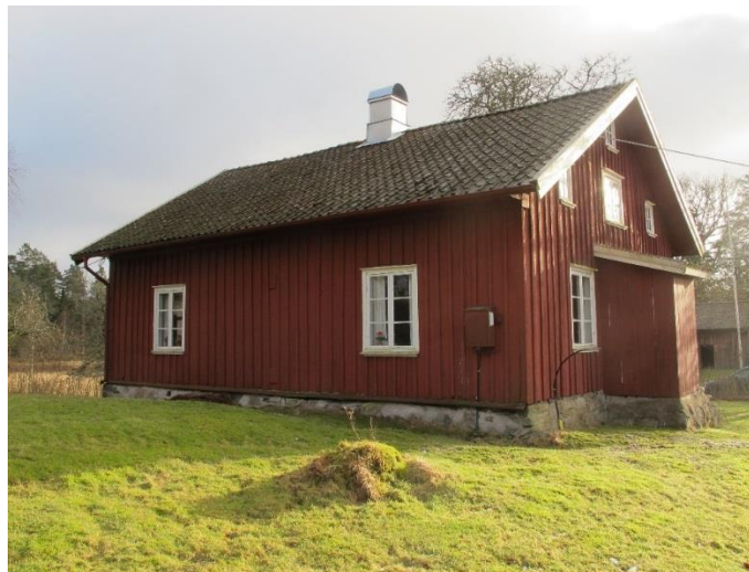
Manbyggnaden från nordväst
